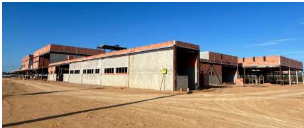
Prédio do Hospital
