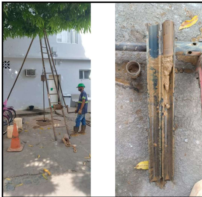
Locação dos serviços na posição sp01.
