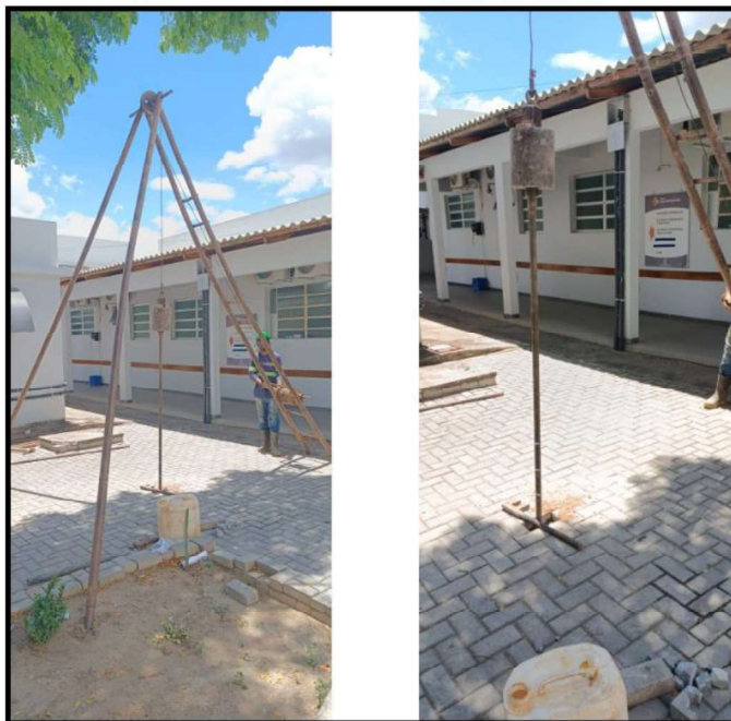
Locação dos serviços na posição sp03.
