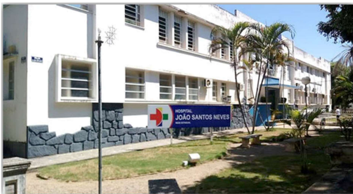
Figura 1 – Hospital João dos Santos Neves, em Baixo Guandu-ES
