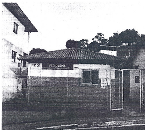
FACHADA DA UBS
