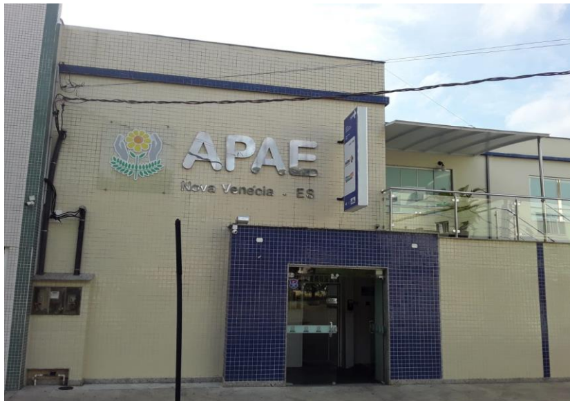
Fig. 1 a 3 – Fachada da Instituição
