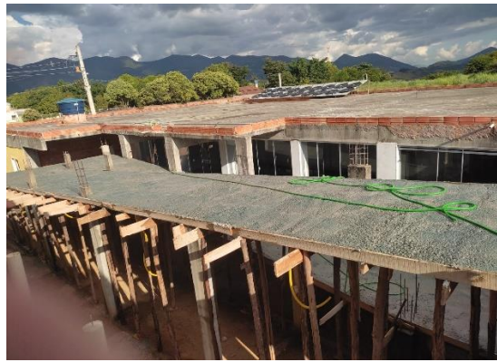
Área da Piscina, aquecedor da piscina e obra da rampa
