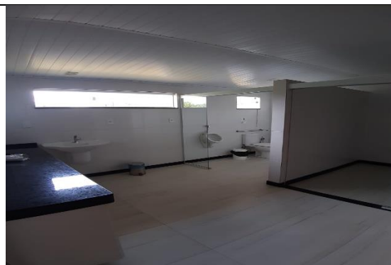
Banheiro da Sala de Academia Masculino
