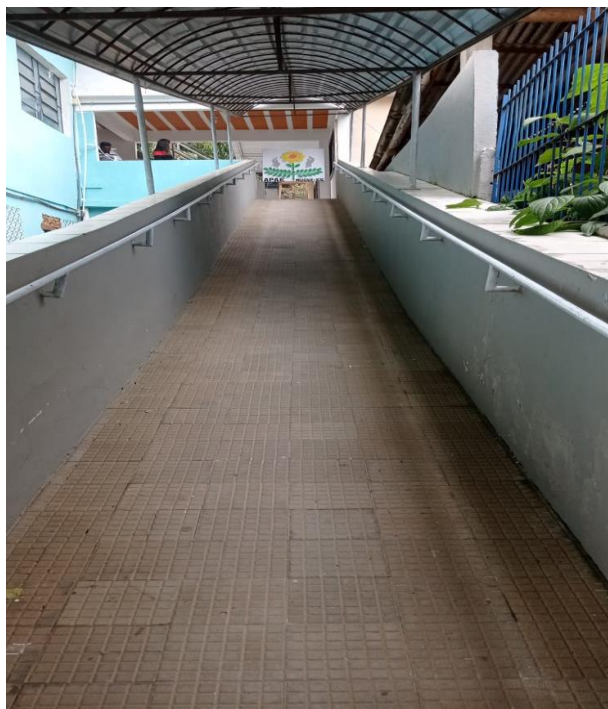
Rampa de acesso ao 1º piso
