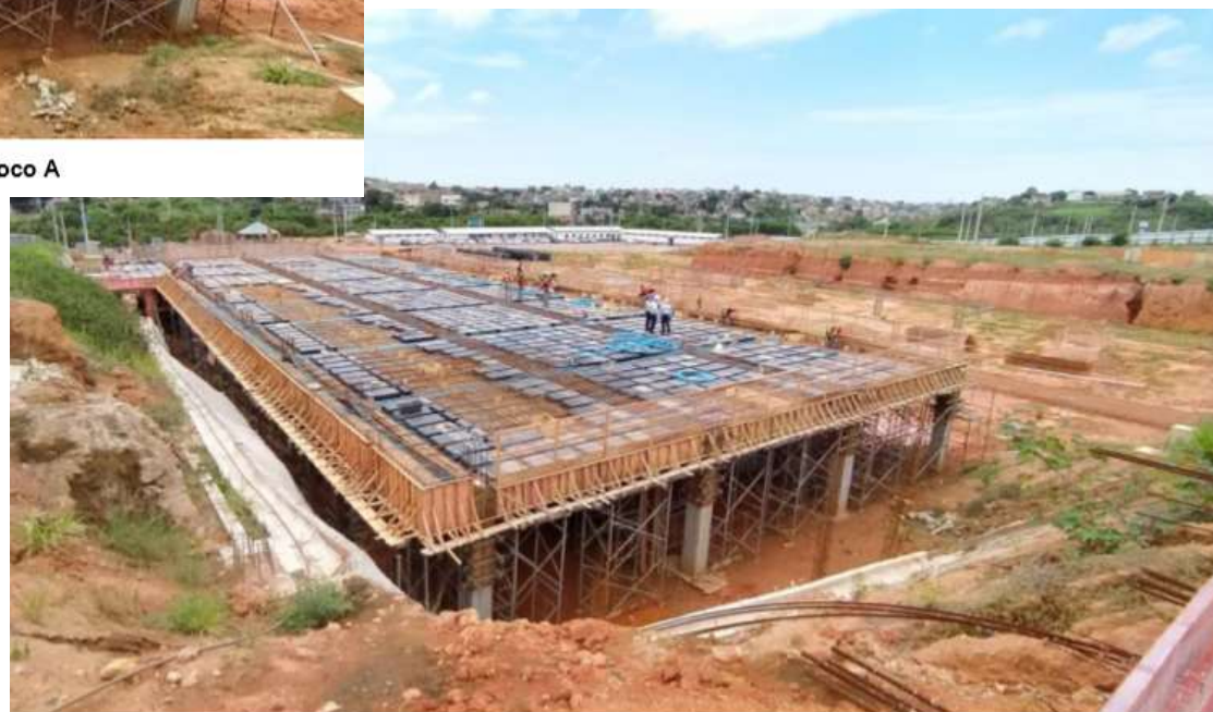
Figura 3 – Execução da Supraestrutura do Bloco A
