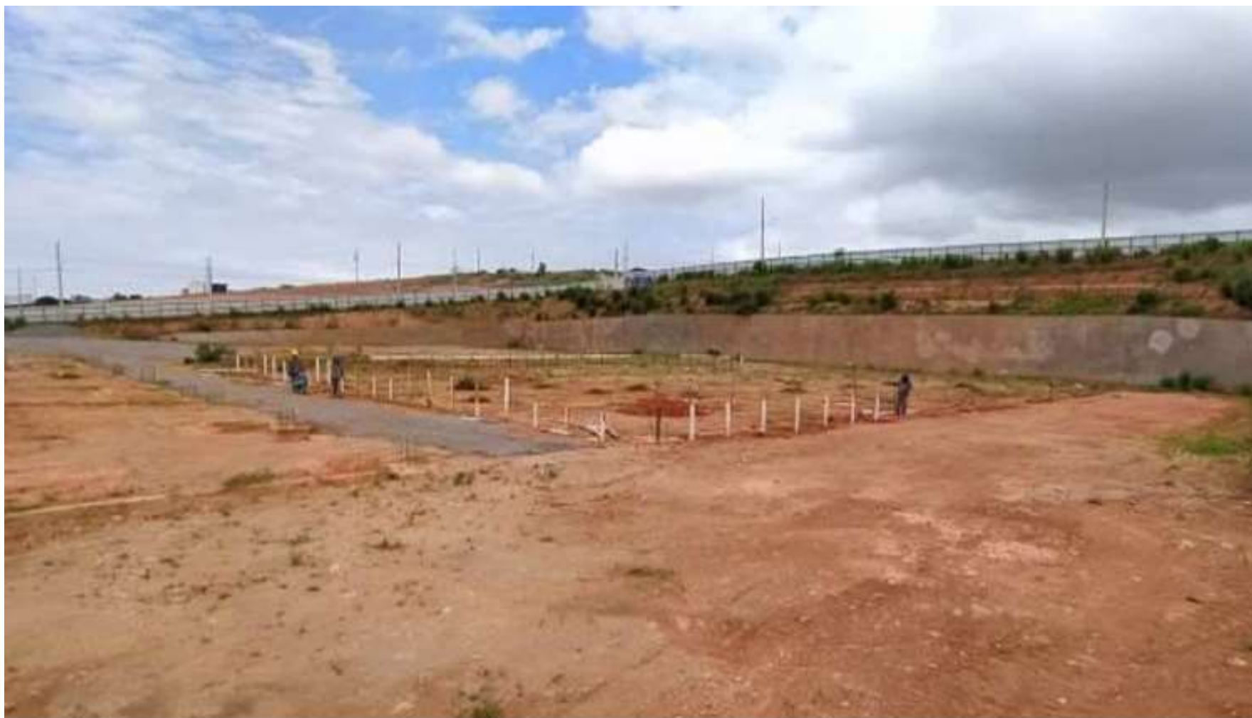
Figura 4 – Locação do Bloco D com gabarito de madeira
