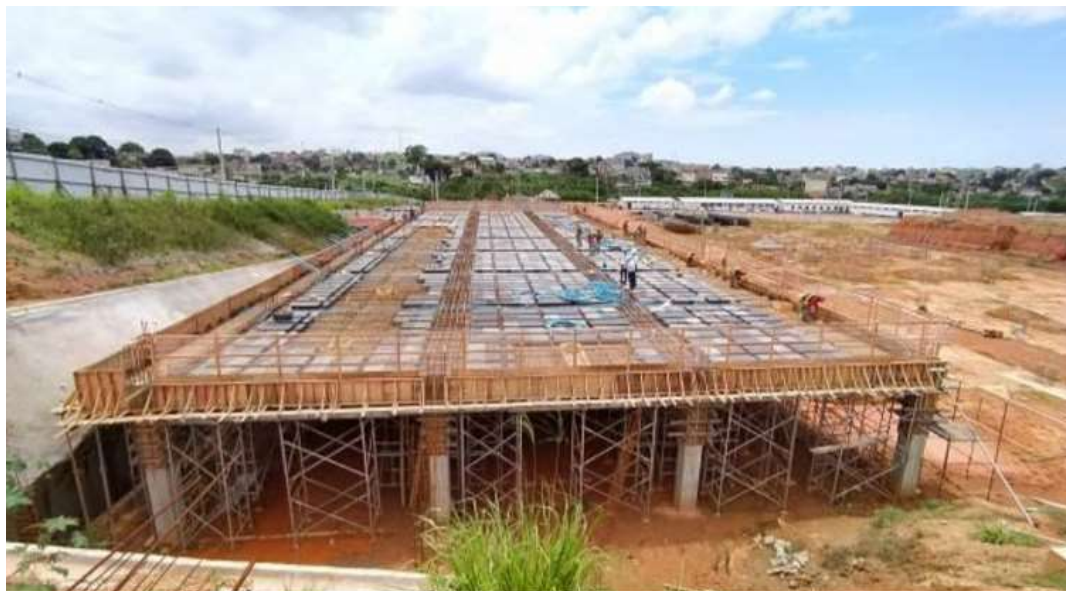
Figura 2 – Execução da Supraestrutura do Bloco A
